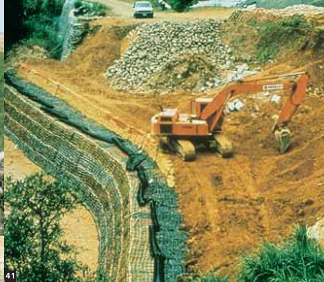
40-41. Sistemazione di una scarpata con geogriglia, Tapei-Taiwan.
