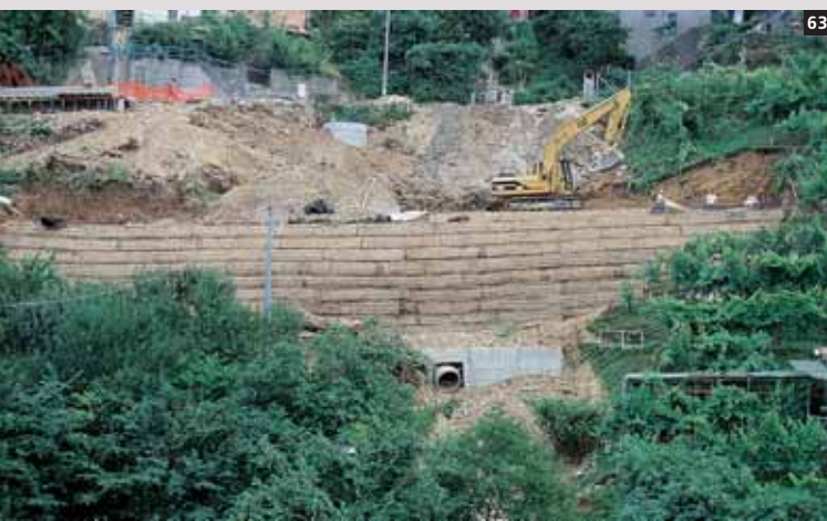
63. Opera di sostegno in geogriglia per allargamento sede stradale, Arcola (SP)-Italia.
