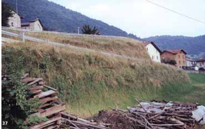
35-36-37. Risistemazione stradale con opere di sostegno in Terramesh® verde, Valle d'Ogna (BG)-Italia.
