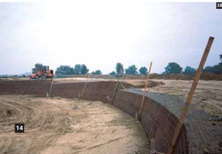
38-39. Muro di sostegno di sottoscampa in Terramesh® verde, Civitanova Marche (MC)-Italia.
