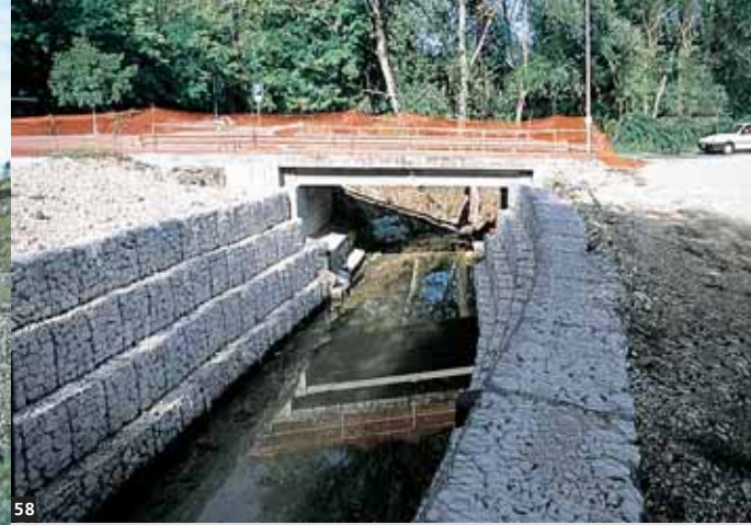
58. Sistemazione idraulica in Terramesh® S e gabbioni torrente, Vella, Sulmona (AQ)-Italia.
