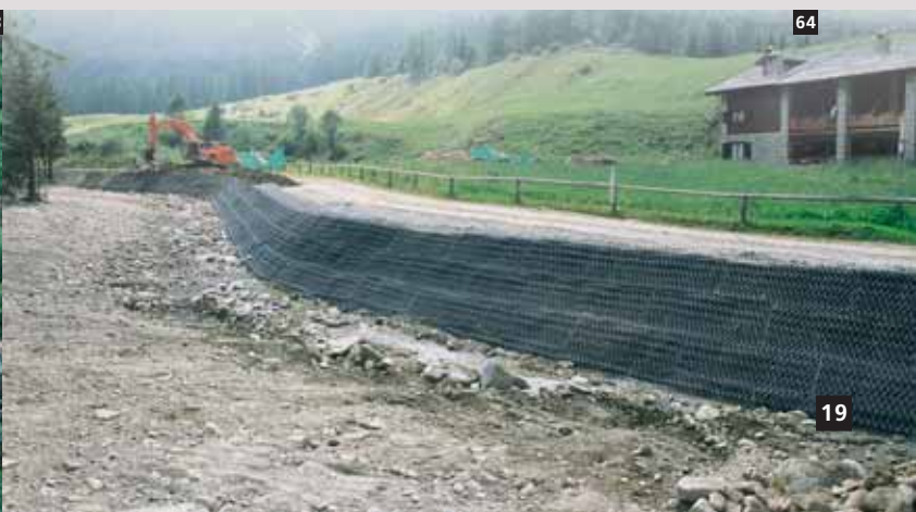
64. Protezione idraulica con Terramesh® verde tipo acqua, Cogne (AO)-Italia.
