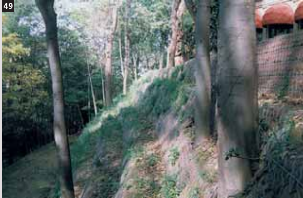
49. Opera di sostegno in Terramesh® verde, Bologna-Italia.
