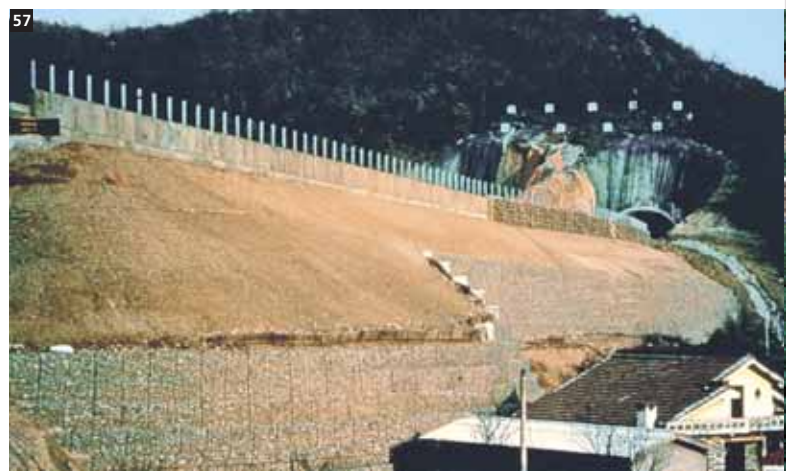
57. Opera di sostegno in Terramesh® S, per l'allargamento sede autostradale, Youg Doug Express Way-South Korea.
