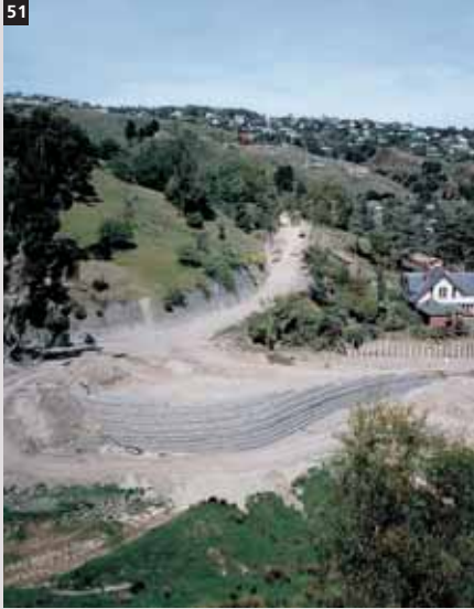
51. Opera di sostegno in Terramesh® S per un nuovo insediamento residenziale, Christchurch,-Nuova Zelanda.
