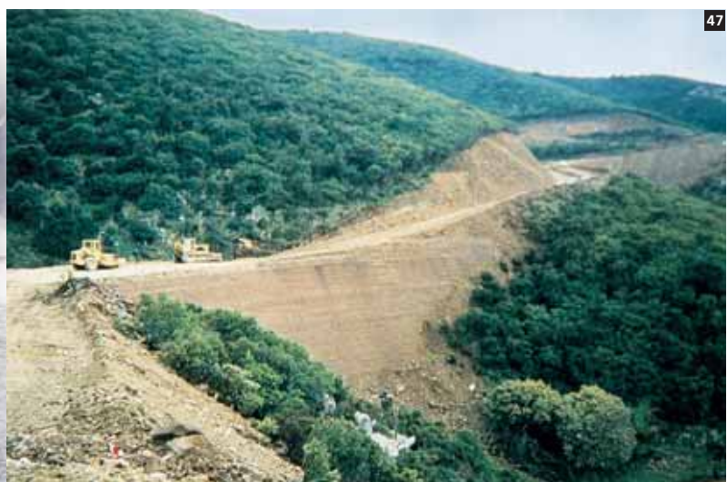
47-48. Rilevato stradale in struttura mista geogriglia - Terramesh® verde, Villamassargia (CA)-Italia.
