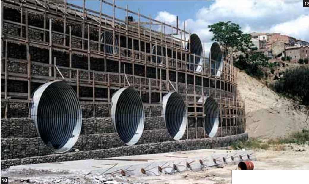
18-19. Opere di sostegno in Terramesh®S e geogriglie, Aliano (MT)-Italia.
