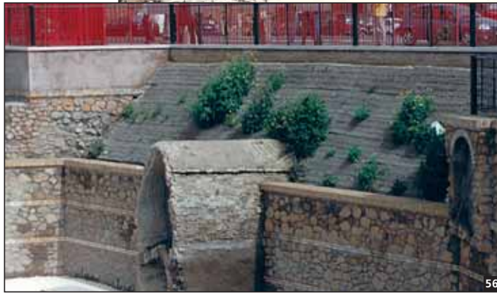
55-56. Opera di sostegno in Terramesh® verde nel sito archeologico dei Fori Imperiali, Roma-Italia.
