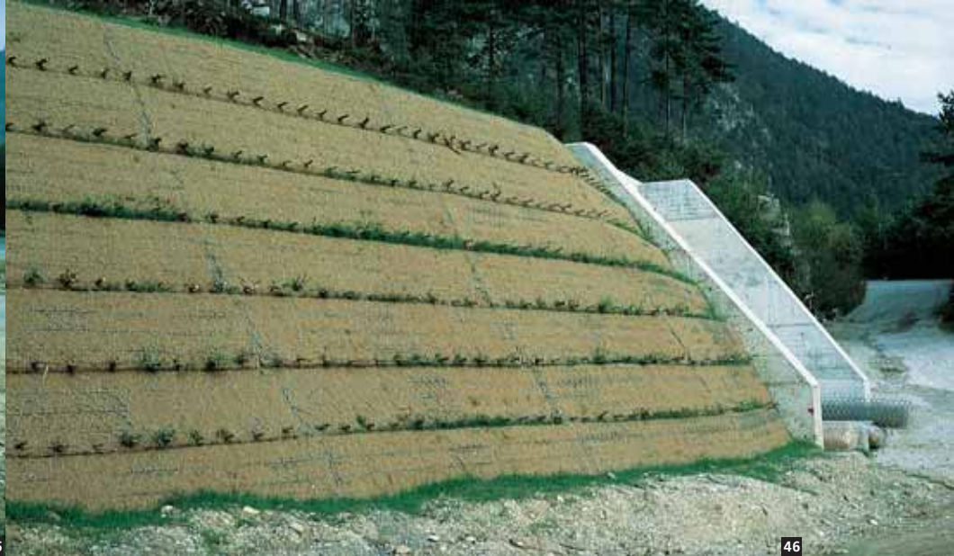
45-46. Opera di sostegno e sistemazione idraulica con Terramesh® verde Ugovizza (UD)-Italia.
