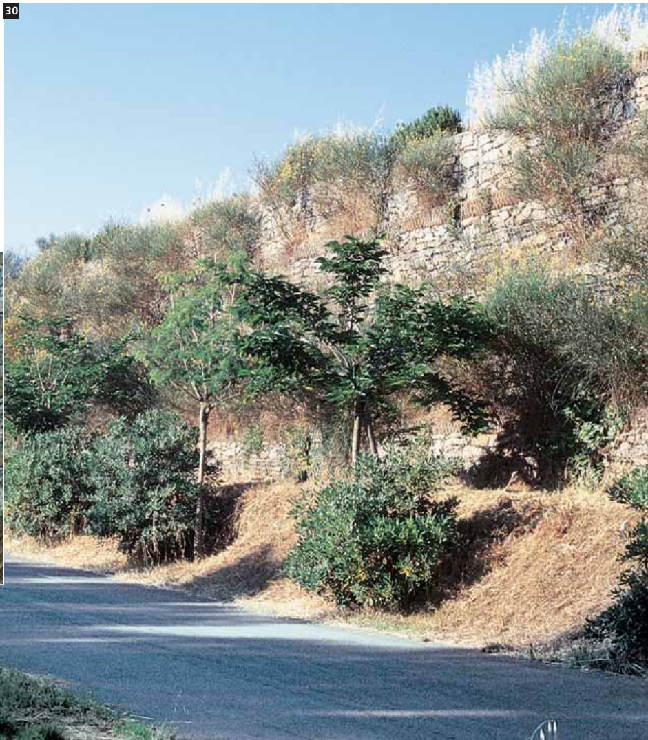
29-30. Barriera antirumore a protezione di nuovo insediamento turistico, realizzata con elementi Terramesh® S lungo la ferrovia Roma-Pisa, S.Vincenzo (LI)-Italia.
