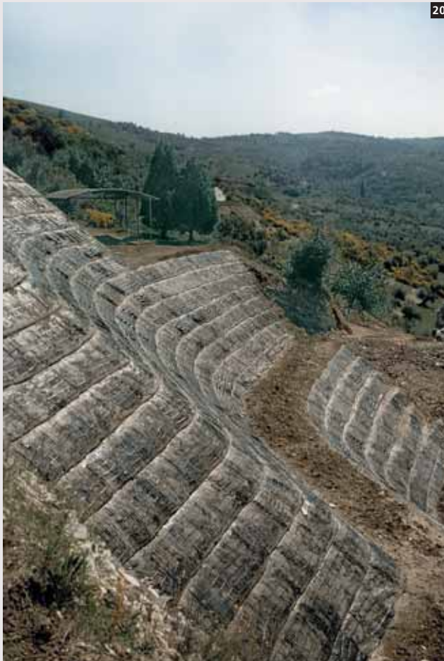
20-21. Stabilizzazione della scarpata in geogriglia, Passignano (PG)-Italia.
