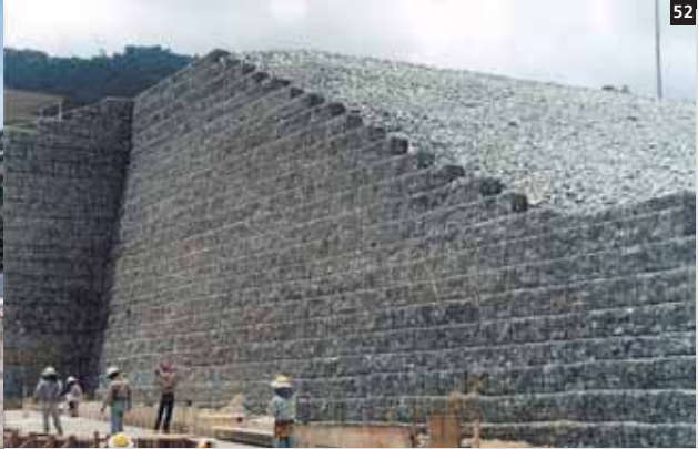
50. Opera di sostegno per la costruzione di parcheggi in Terramesh® verde, Ariccia (RM)-Italia.
