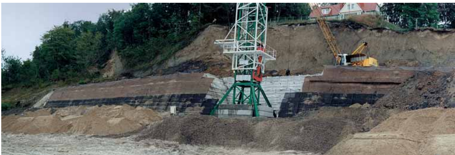
54. Sistemazione di scarpata, Jastrzebiej Gorze - Polonia.
